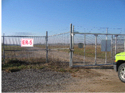
Barrière ER-5 - vue du côté piste
