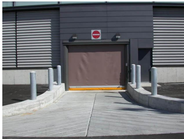
Sortie des véhicules de la salle de bagages – Vue du chemin « Head of Stand » Notez le panneau sens interdit.
