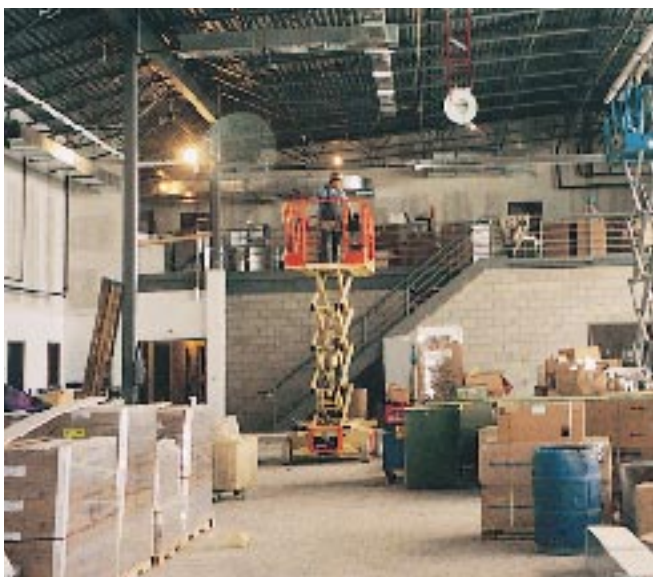
La construction de l'édifice des services intégrés va bon train à l'intersection des pistes d'atterrissage de l'aéroport.
